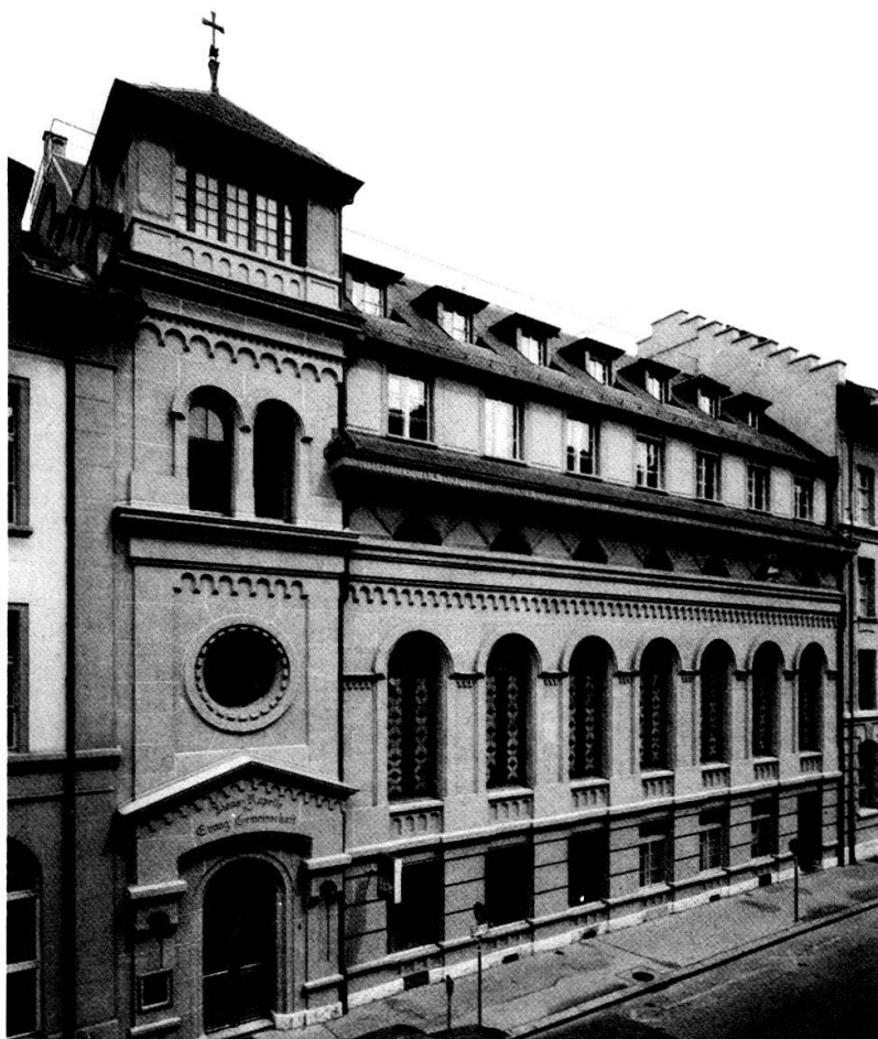
Südfront der Zionskapelle nach der Renovation.
