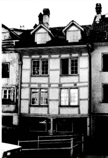
Gerberngasse 44: Gassenfassade, oben vor der Renovation, unten nach Freilegung der Riegkonstruktion und mit neuen Dachaufbauten.
