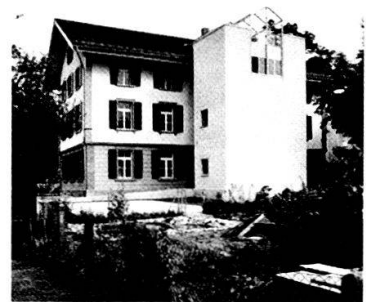
Dorfschulhaus Bümpliz: An-sicht der Rückseite mit Anbau von 1984/85.
