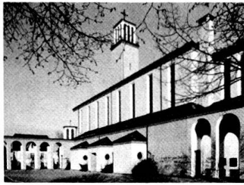
Marienkirche: Ansicht von Südosten, Zustand 1983.
