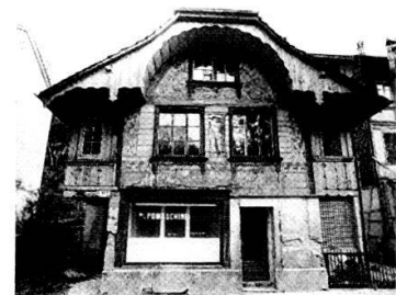
Altenbergstrasse 102: Zustand vor der Renovation 1981.
