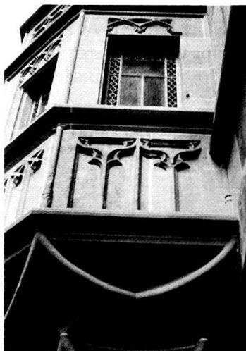
Erker des Mayhauses: Netzrippen des Erkerkorbes und erstes Geschoss von Osten, mit wiederverwendeten Sandsteinteilen und beibehaltener Vergrößerung der Fenster, nach der Rekonstruktion 1985.
