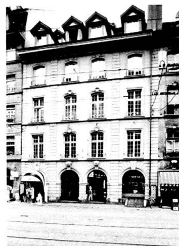
Spitalgasse 38: Gassenfassade nach der Renovation 1980/81.
