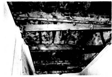
Postgasse 22: Decke im Nordzimmer des 2. Stocks, Fundzustand; gegenüberliegende Seite: Decke nach der Restaurierung 1984.
