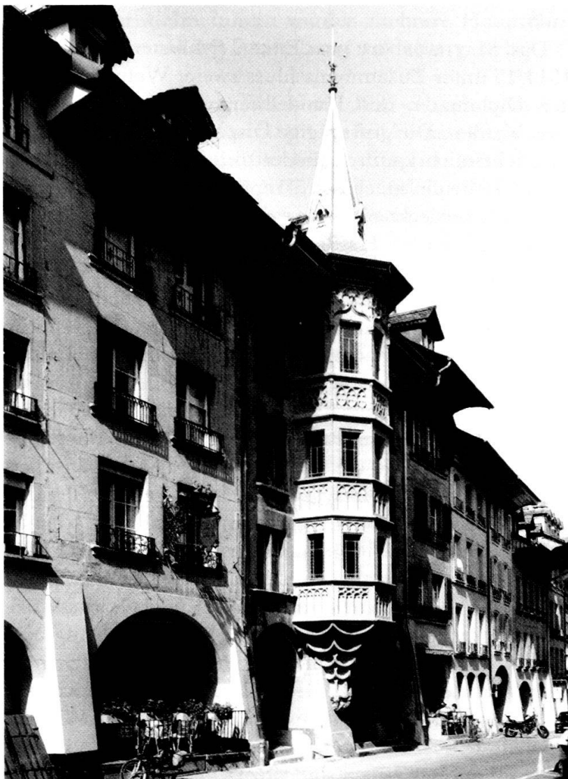
Erker des Mayhauses: Netzrippen des Erkerkorbes und erstes Geschoss von Osten, mit wiederverwendeten Sandsteinteilen und beibehaltener Vergrößerung der Fenster, nach der Rekonstruktion 1985.
