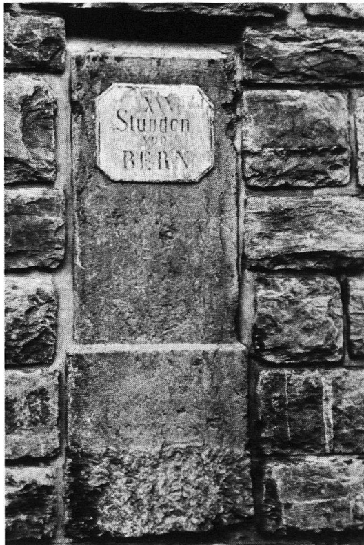
3 Mit Sockel und unbehauener Partie in eine Stützmauer eingebauter Stundenstein bei Lauterbrunnen (Nr. 1414).
