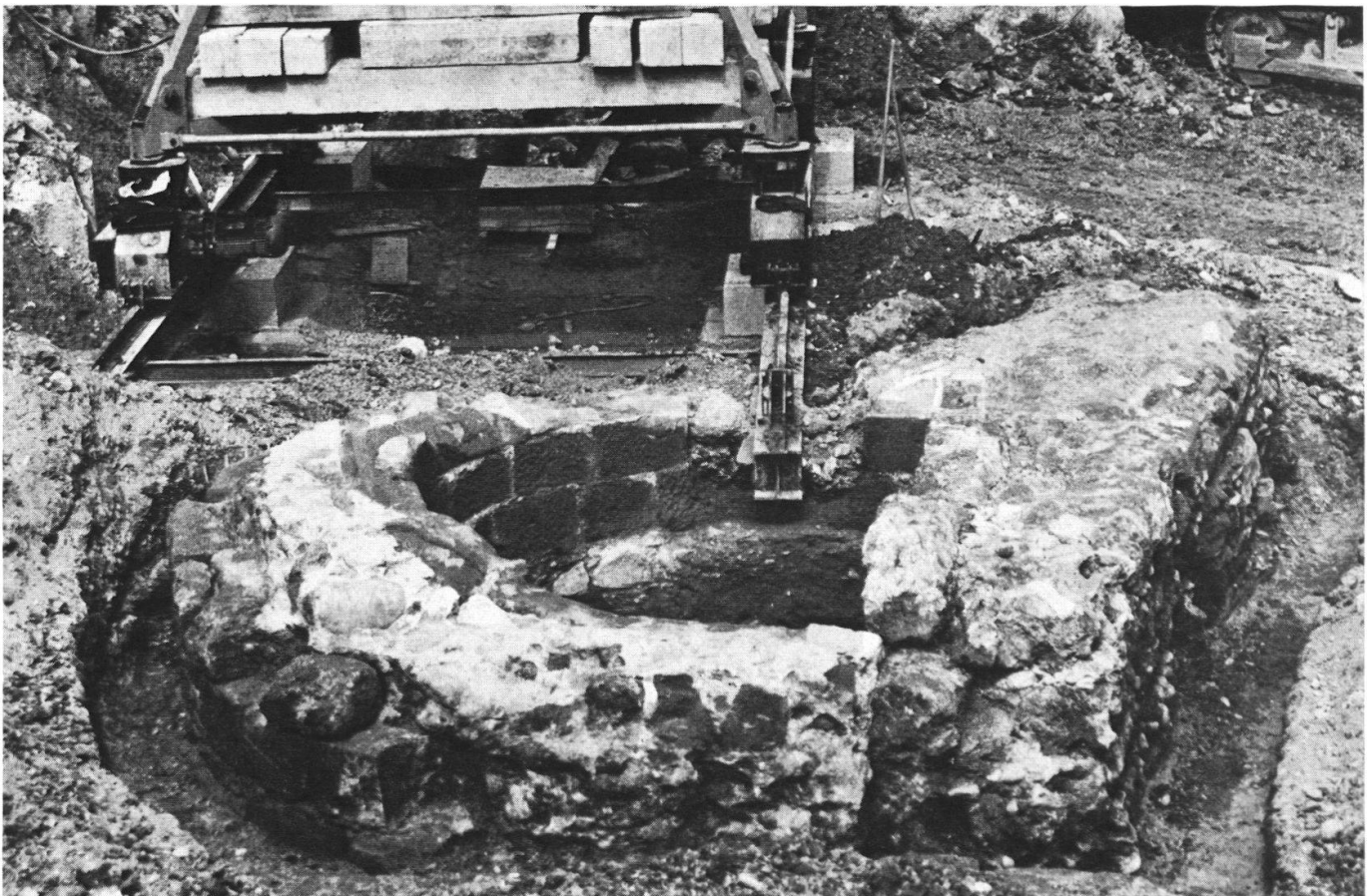
Abb. 8: Erster halbrunder Turm nördlich des Christoffelturms. Ansicht von Süden mit dem Ringmauerabschnitt 4 b.
