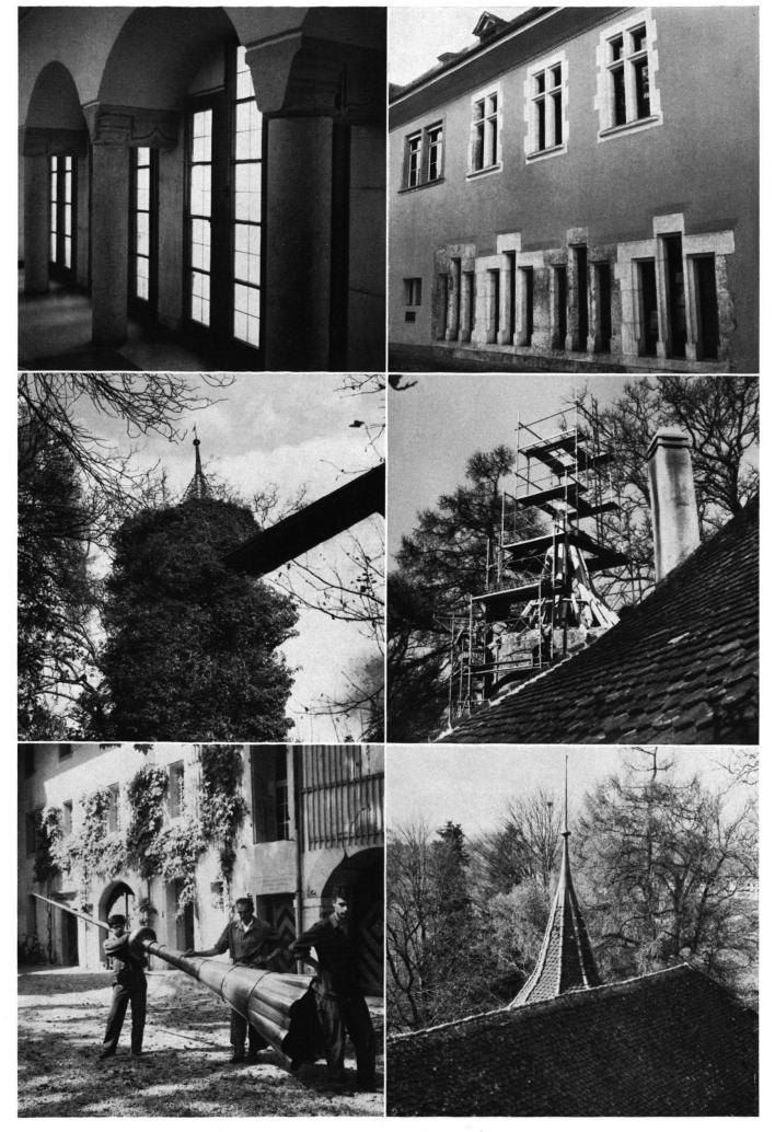
En haut: Delémont, Châtelet, fenêtres gothiques après restauration et meneaux en calcaire et aux chapiteaux profilés Mitte und unten: Schloß Landshut, Gefängnisturm; Restaurierung; Aufsetzen einer neuen Helmspitze aus Kupfer
