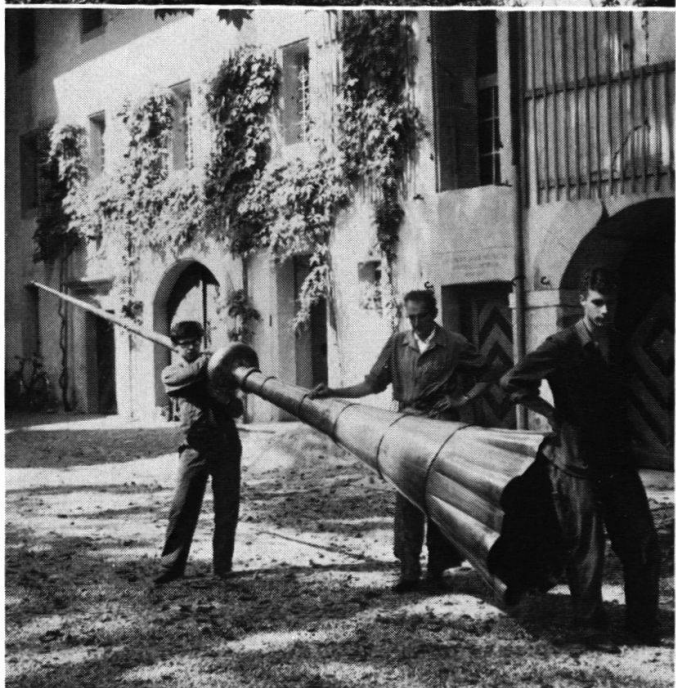
En haut: Delémont, Châtelet, fenêtres gothiques après restauration et meneaux en calcaire et aux chapiteaux profilés Mitte und unten: Schloß Landshut, Gefängnisturm; Restaurierung; Aufsetzen einer neuen Helmspitze aus Kupfer
