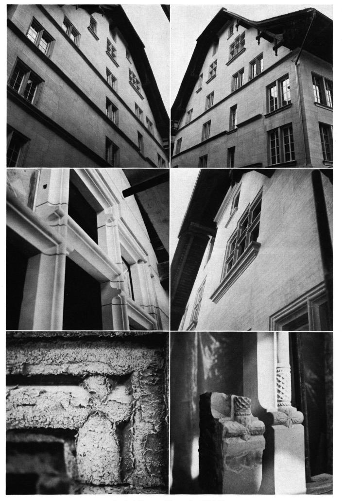
${\it Burgdorf, Haus zum Ochsen, erbaut 1627/1629} \\ {\it Oben und Mitte:} \ {\it Restaurierte Fassade} \\ {\it Unten:} \ {\it Links v\"{o}llig zersetzter Sandstein. Rechts Original und Kopie eines Stabfußes}$
