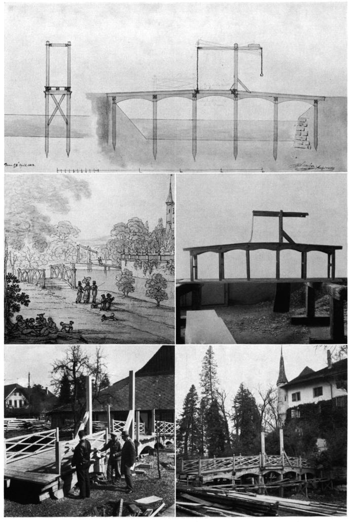
Schloß Landshut, Rekonstruktion der alten Zugbrücke Oben: Originalplan von Architekt F. Schnyder, 1813
