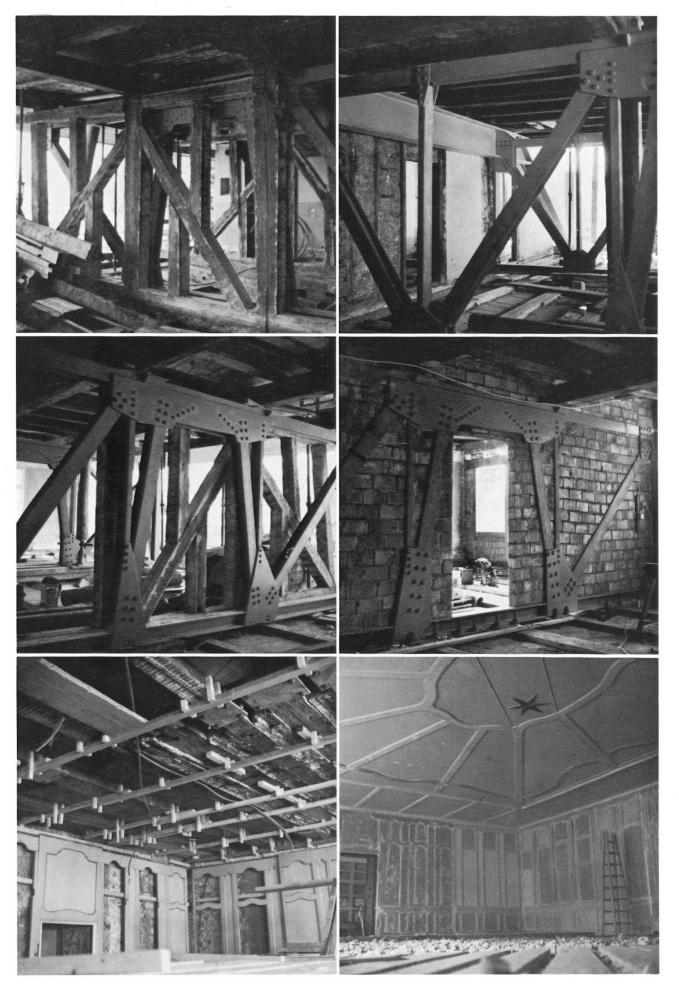
Rathaus Thun. Oben und Mitte: Konsolidierung des Gebäudes durch Stahlkonstruktionen, die die alten, stark abgesenkten Holzkonstruktionen ersetzen. Unten: großer Stadtrats-Saal während der Restaurierung.
