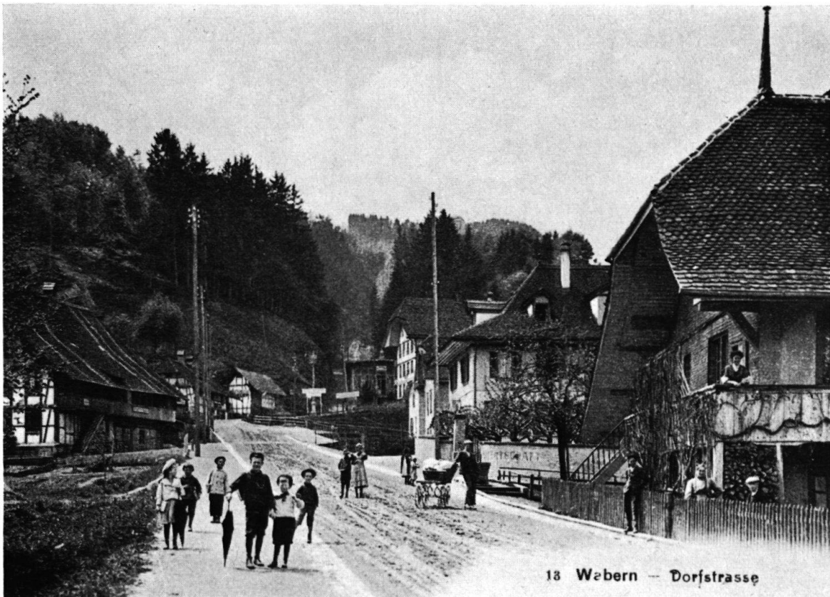
Oben: Großwäbern um 1914. Das 1908 errichtete dritte Dorfschulhaus und die Villa «Sommerlust» Ecke Dorfstraße/Seftigenstraße, links das Sprengergut.
