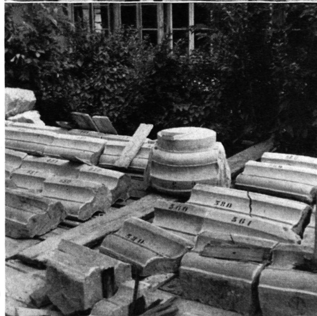
St. Johannsen: Zerlegung des Chors. Photos Architekt A. Schaetzle und H. v. Fischer
