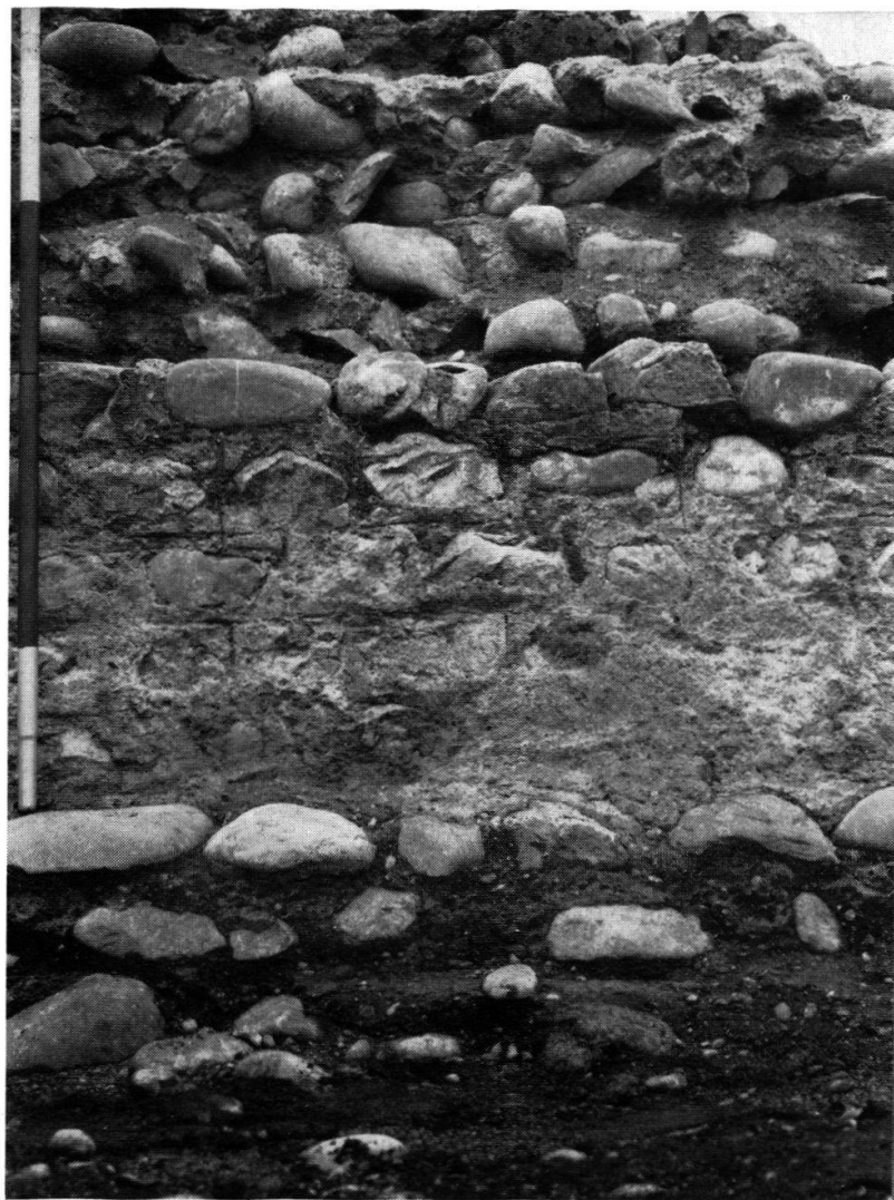
Arenamauer vom Innenraum her gesehen. Unten: Vorfundament; Mitte: Front mit Fugenstrich, Putz und Bemalung; Oben: Durch Ausbrechen der Innenfront freigelegter Mauerkerne mit deutlicher Schichtung.
