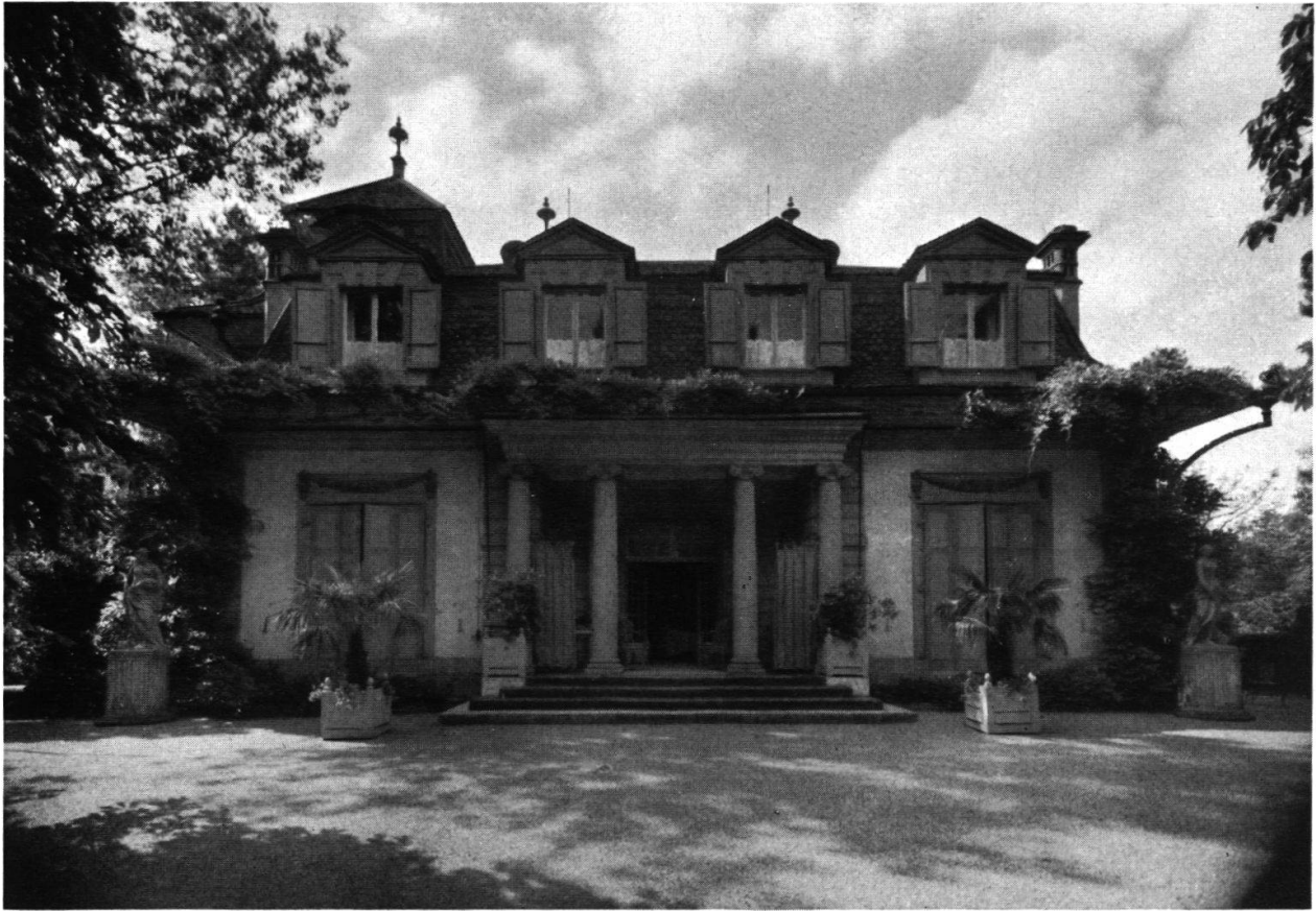
„Le Pavillon“. Eigenheim des Architekten, Thunstraße 15, Bern Gartenfassade gegen Osten hin
