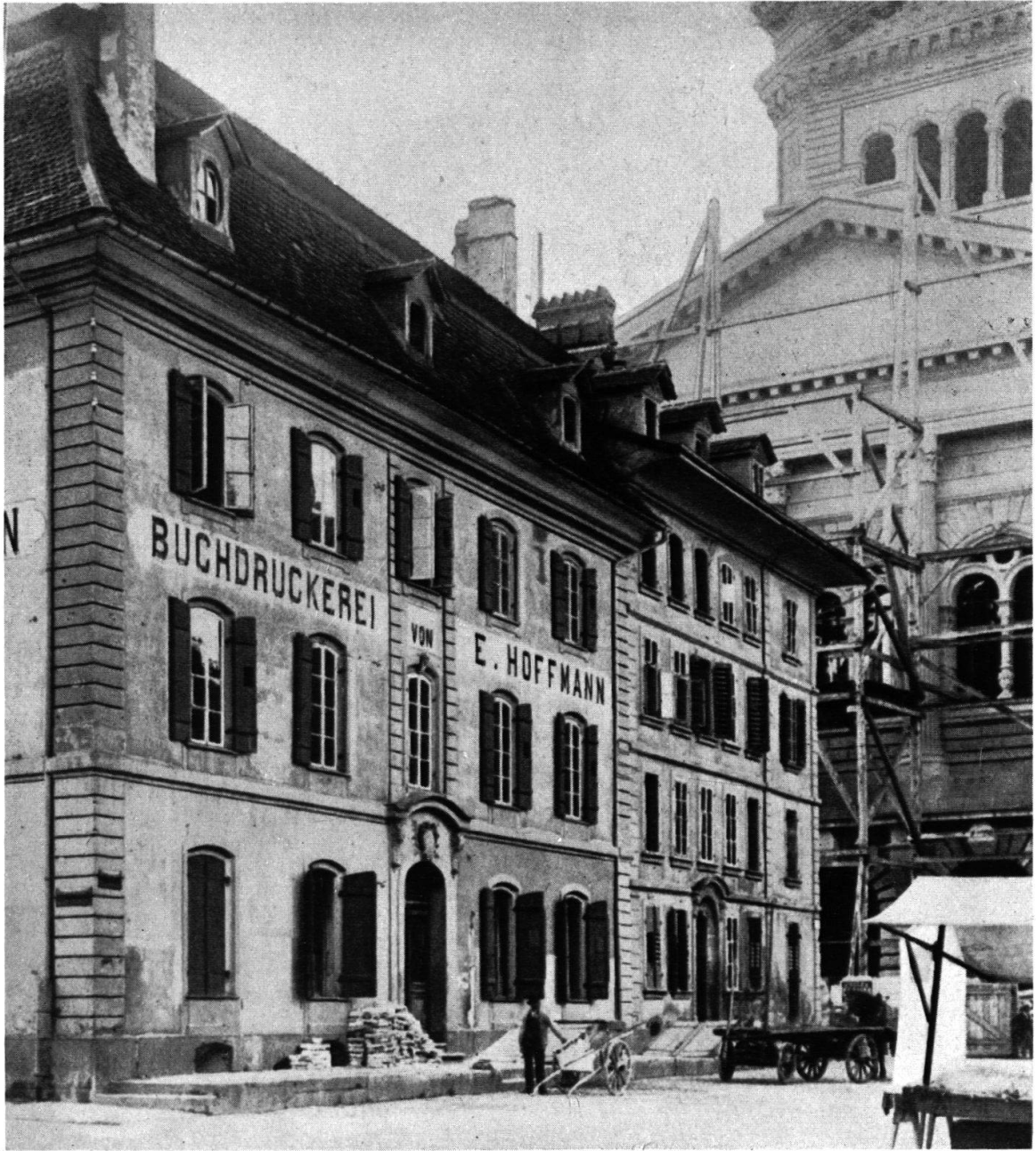
Das Parlamentsgebäude am Bundesplatz im Bau.
