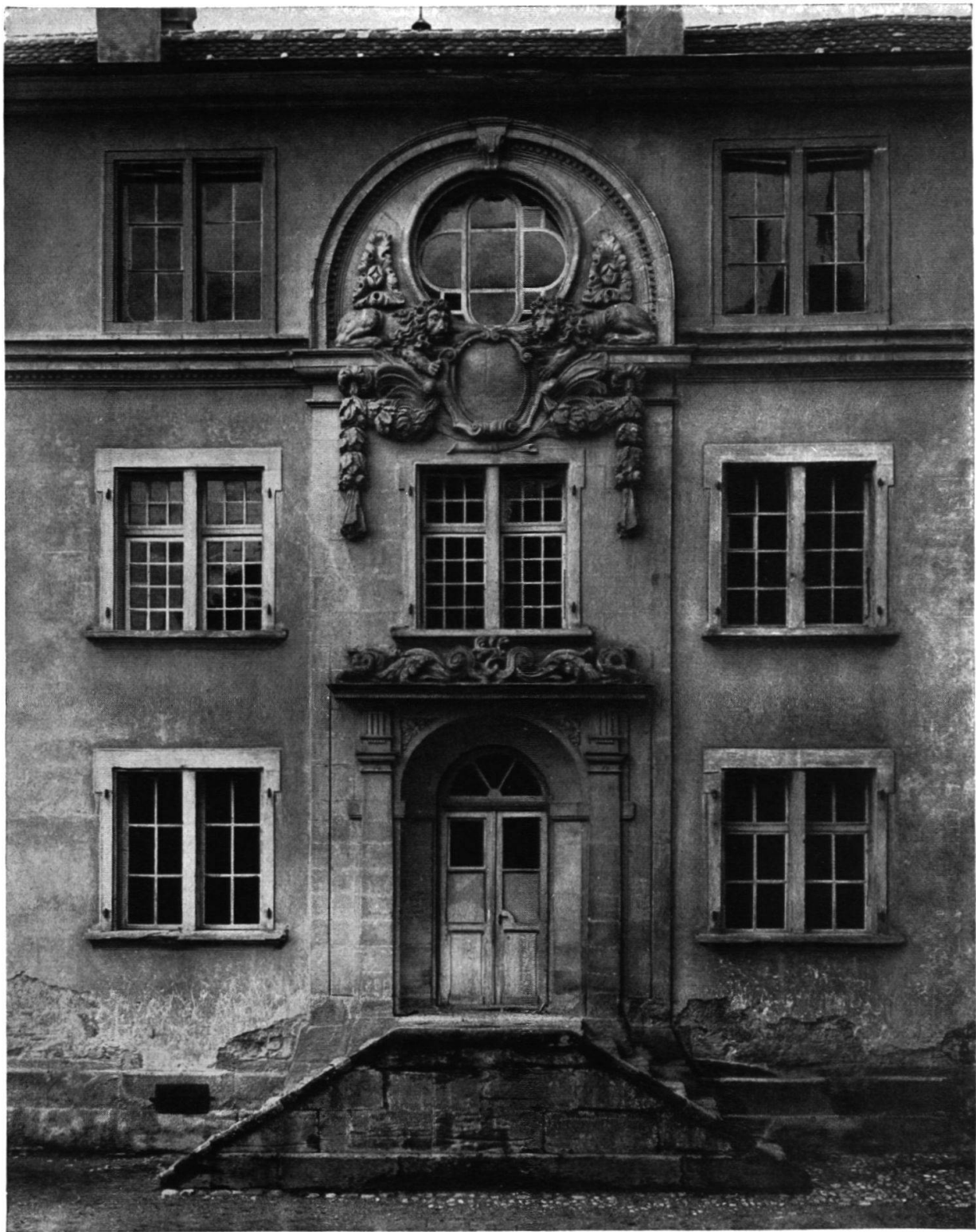
Alte Hochschule, Ostfassade. Hauptportal 1682/3, Attikageschoss um 1864 aufgesetzt. Aufnahme kurz vor Abbruch um 1900. Vgl. Reg. 62-70
