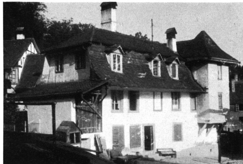
Altenbergstraße 20. Einst Kloster, dann aml. Gebäude, heute Miethaus.
