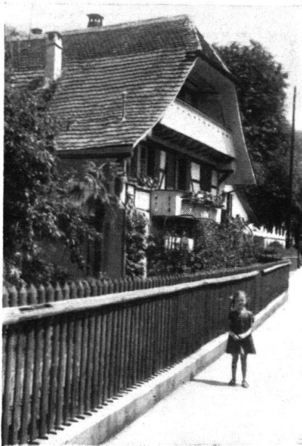
Altenbergstraße 19, «Hüttli» Südfassade
