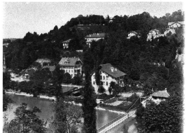
Westlicher Teil des Altenberges L.: Altes und neues Bärttschihaus R.: Zollhäuschen
