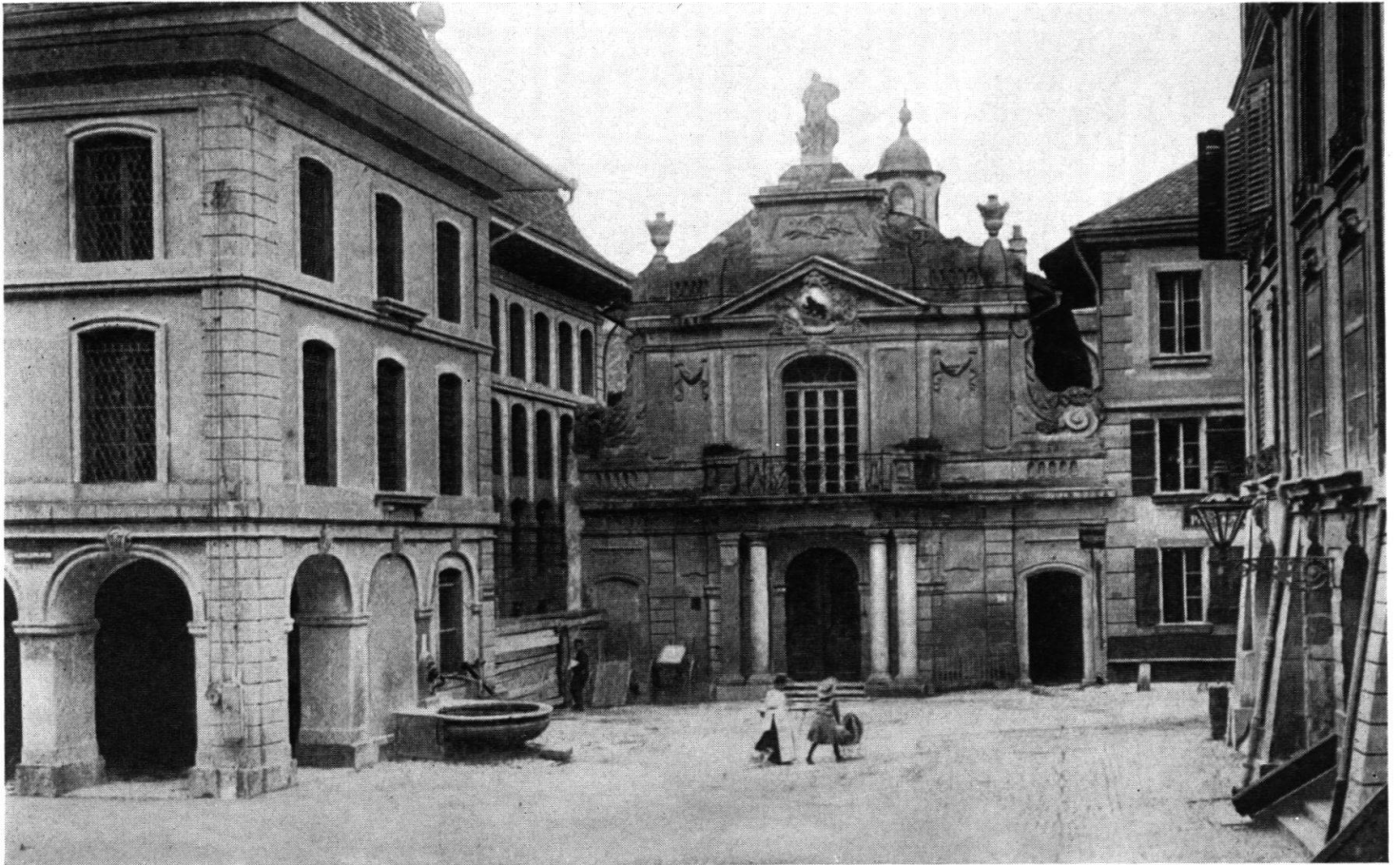
Bibliotheksgalerie (ehemaliges Historisches Museum), erbaut von Niklaus Sprüngli 1775 im Blickfang der Hotelgasse, abgebrochen 1909.
