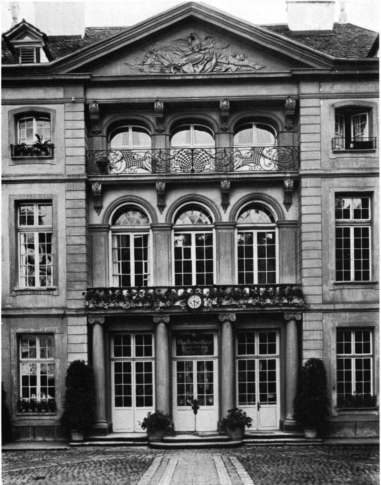
Der Erlacherhof seit 1748/52, Hofansicht. Säulen- und Bogenstellungen des Mittelrisalits des Hauptflügels.
