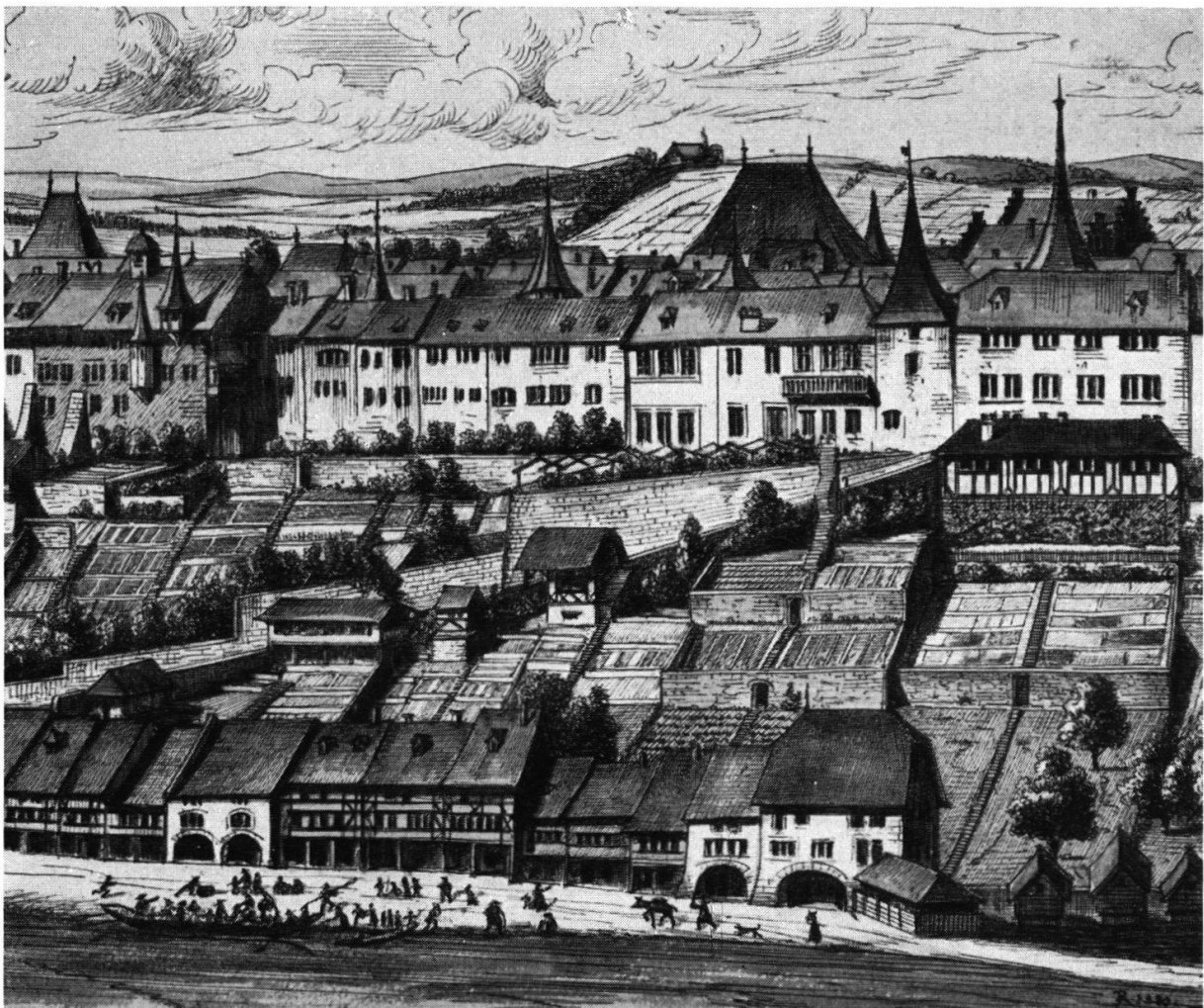
Abb. 3. Aus Albrecht Kauws Stadtansicht von 1665, nach der Umzeichnung von Eduard von Rodt. Die Erlachhäuser von Süden nach der Umgestaltung des Hinterhauses (Landseite) durch Sigmund von Erlach 1654/55.
