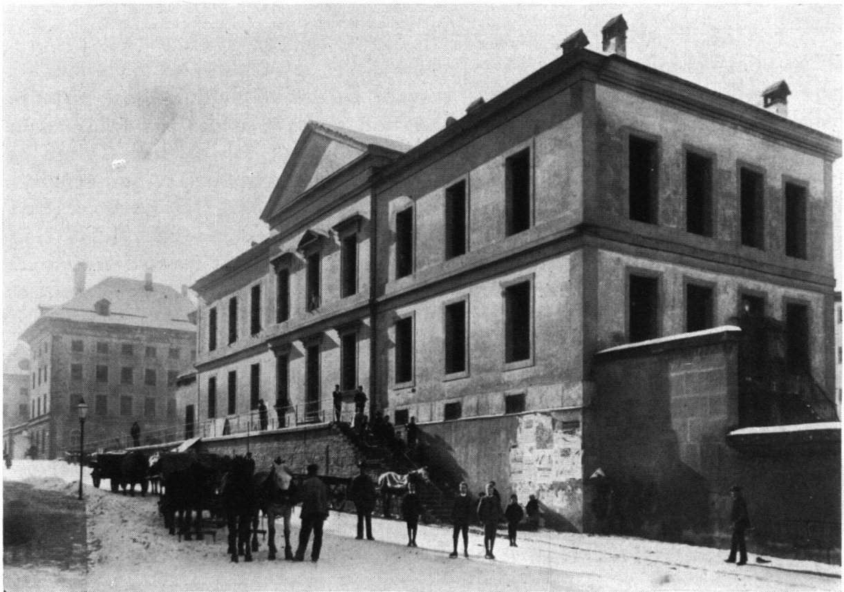
Das dritte anatomische Institut in Bern bei Beginn des Abbruches (Frühjahr 1898), nach Lichtbildern aus dem Besitz der Stadt- und Hochschulbibliothek Bern. Oben eine Rückansicht von der Südseite, unten die Fassade von Nordosten her gesehen.
