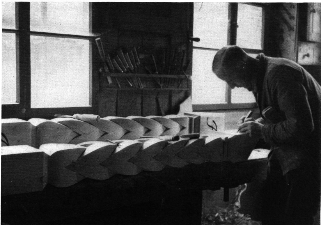
Zimmermann-Lanz am Schnitzen der Büge zur Bühnislaupe, Frühling 1939 in der Speicherwerkstatt. (Photo Fr. Hertig, Sohn.)
