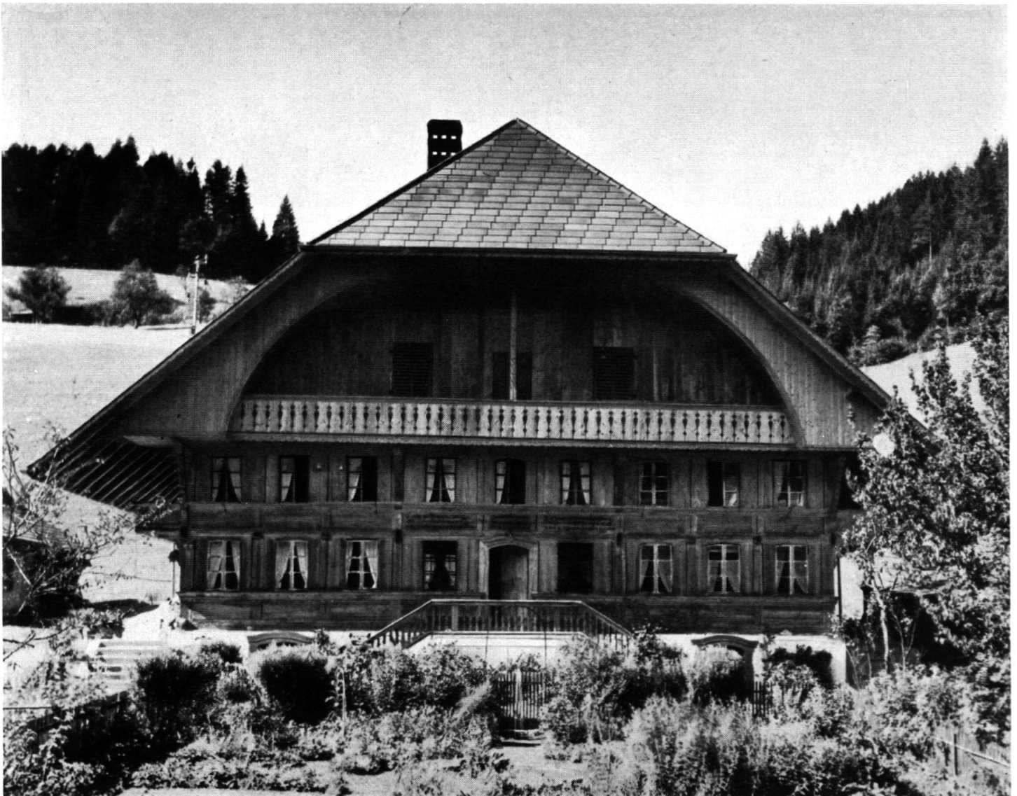
Das Haus, wie es heute steht. Den Umbau besorgte in vorbildlicher Art und Weise Zimmermeister Lanz, Längmatt bei Zollbrück. Man beachte die feingeschwungene Linie der Ründe sowie die einfachen, materialgerechten Laubenausschnitte.
