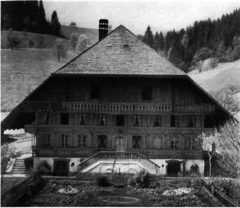
Das Haus vor der Erneuerung des Dachstuhls. Dieser datierte noch aus dem Jahre 1685. Keller, Stuben und Gaden sind in den Jahren 1827—29 neu errichtet worden. Ohne Zweifel ist die Zentrallage der Küche ursprünglich.
