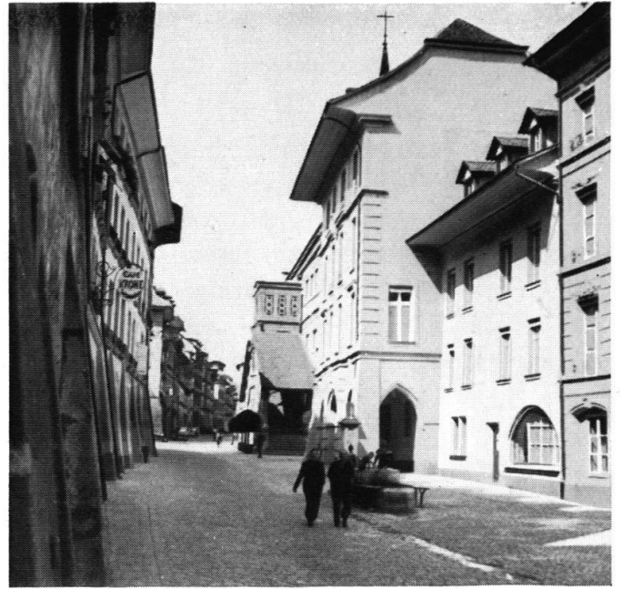
Das alte Staatsarchiv: Ansicht von Osten.
