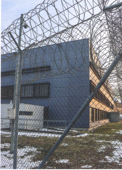
Das Untersuchungsgefängnis in Thun liegt eingepfercht zwischen der Allmendstrasse und den Bahngleisen gegenüber der grossen Militärkaserne im Westen der Stadt. FOTO: IRIS MEYER
