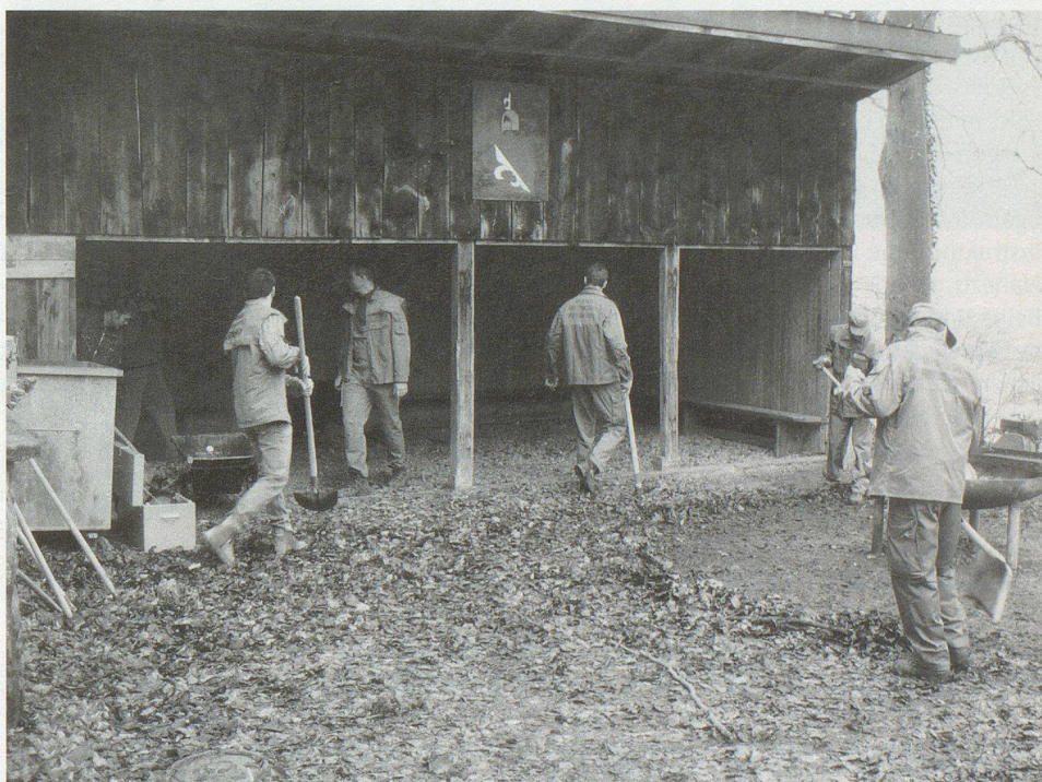
Bald hat das ehemalige Schützenhaus Unterendingen seinen Glanz wieder.
