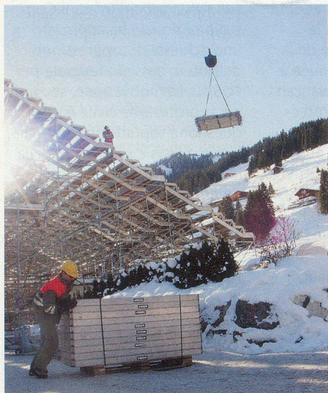
Abbau der Tribüne: hauptsächlich in Handarbeit, schwere Lasten mit dem Kran.
