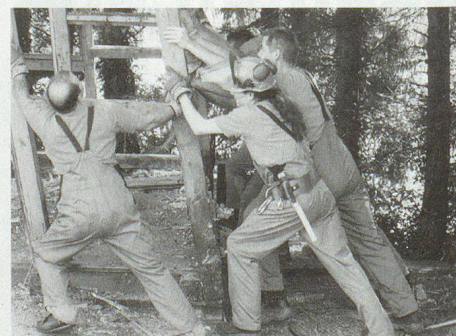
Beim Rückbau der Kläranlage.
