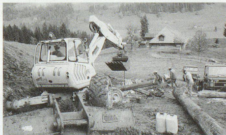
Mit Holzstämmen wird im Gebiet Untere Gemmi (Gemeinde Schangnau) ein neuer Bachlauf errichtet.
