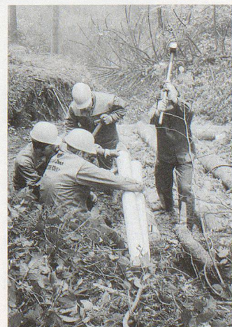
Zivilschützer arbeiten im Gebiet Leimen (Gemeinde Langnau) an einem so genannten Energierichter für den Bach.
