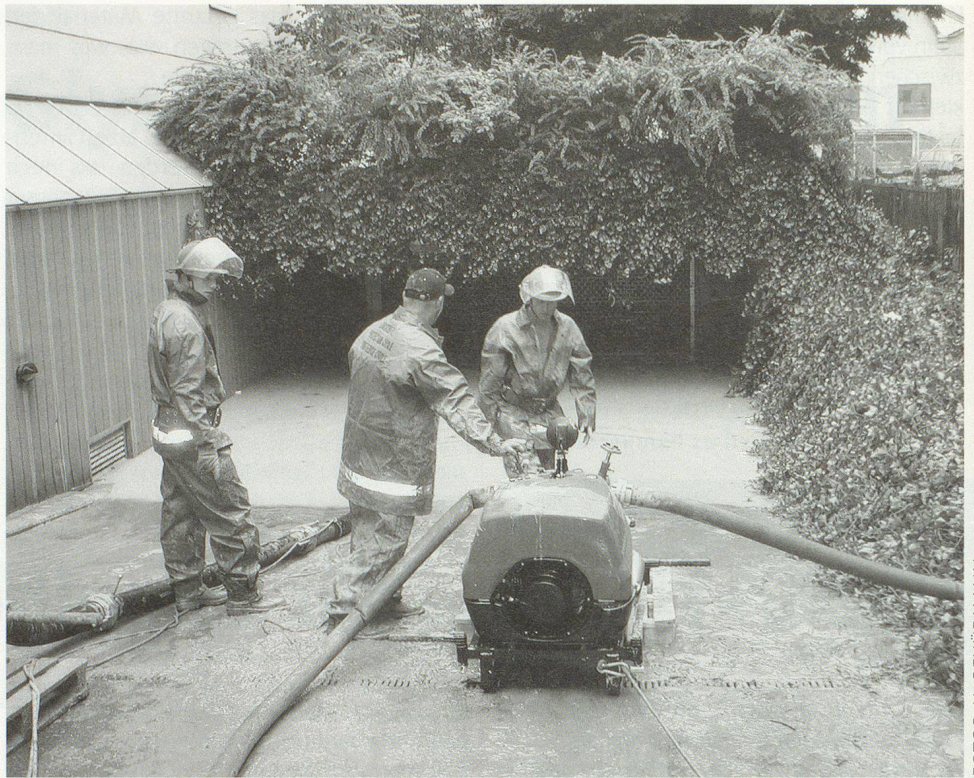
Zivilschützer beim Auspumpen einer Tiefgarage.
