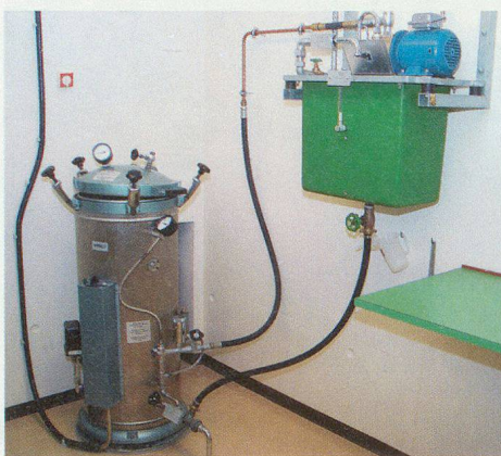
Les stérilisateurs à vapeur sont maintenus dans les constructions protégées. Cependant, ils ne répondent plus aux exigences de l'ordonnance sur les dispositifs médicaux et ne peuvent plus être utilisés en cas de catastrophe et de situation d'urgence sans équipement complémentaire et validation.
