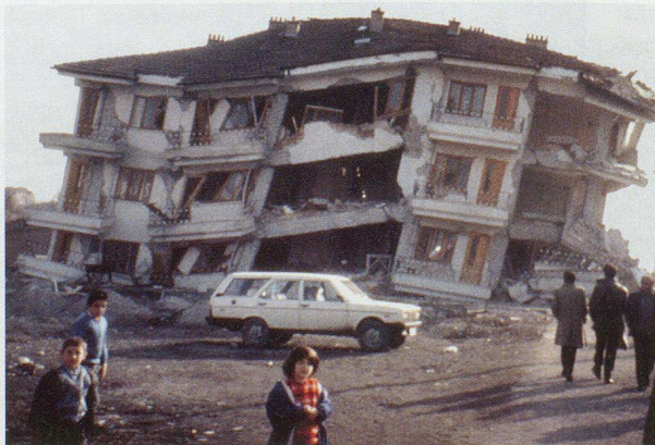
Stahlbetonskelettneubau mit Backsteinausfachungen im Zentrum von Erzincan. Wegen ungünstiger Konstruktions- und Bauweise wurde das Gebäude durch das Erdbeben völlig zerstört.
