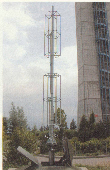
Die Sendeanlagen des Stabes BR APF sollen erhalten und erneuert werden. Zuständig ist künftig der Geschäftsbereich Infrastruktur des Bundesamtes für Bevölkerungsschutz.
