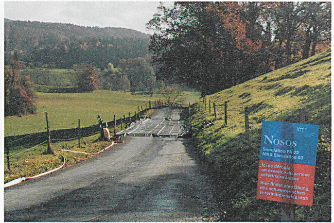
Zone de désinfection des véhicules avec le bac de récupération des eaux usées.
