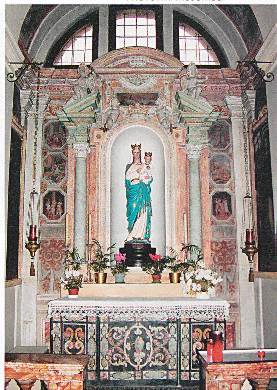
L'église Santa Maria delle Grazie est en restauration. Les participants ont pu examiner de nombreux détails de près.
