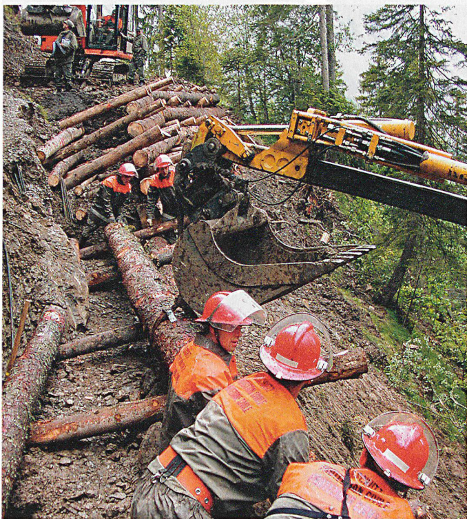
Kastenbau in unwegsamem Gelände.
