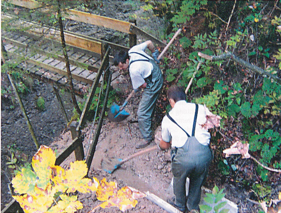
Beim Verlegen einer Betonhalbschale zur Wasserführung im Chratztobel.
