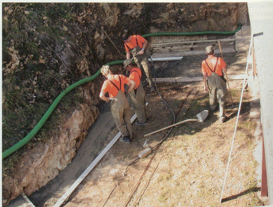
Assainissement: construction d'un mur et d'un drain.
