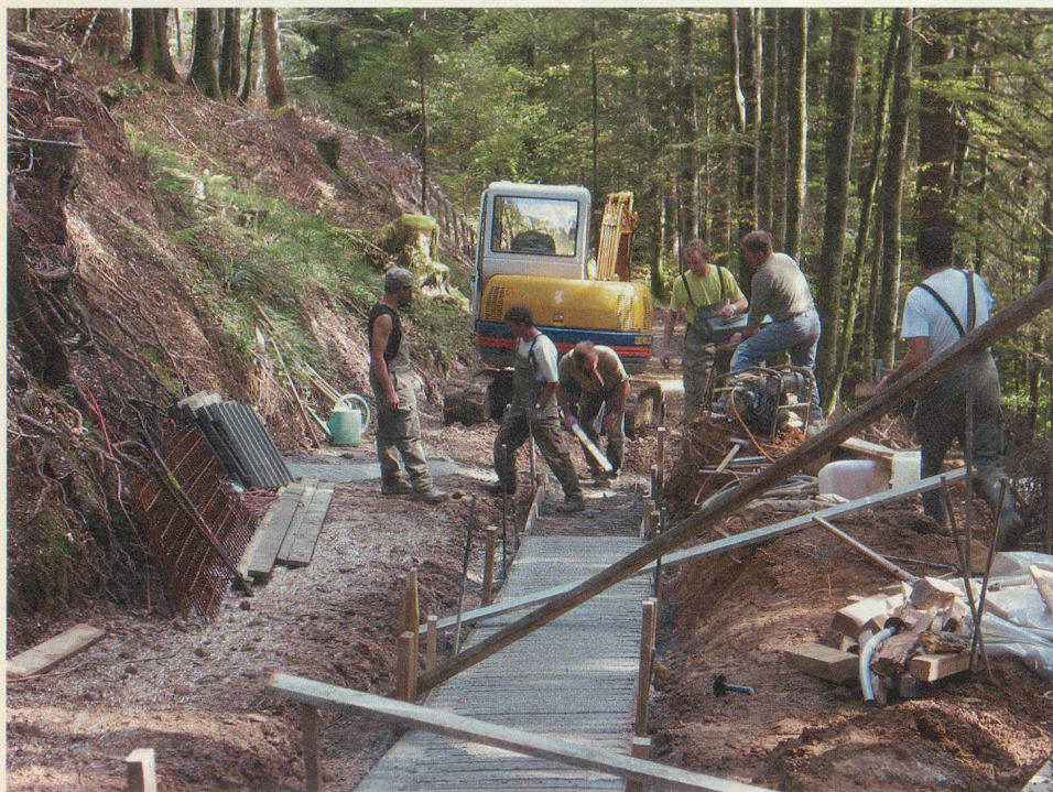
Mit dem Einbau einer Fahrrinne im steilsten Stück zur Wideregg wird das Befahren auch bei schlechtem Wetter sicherer.
