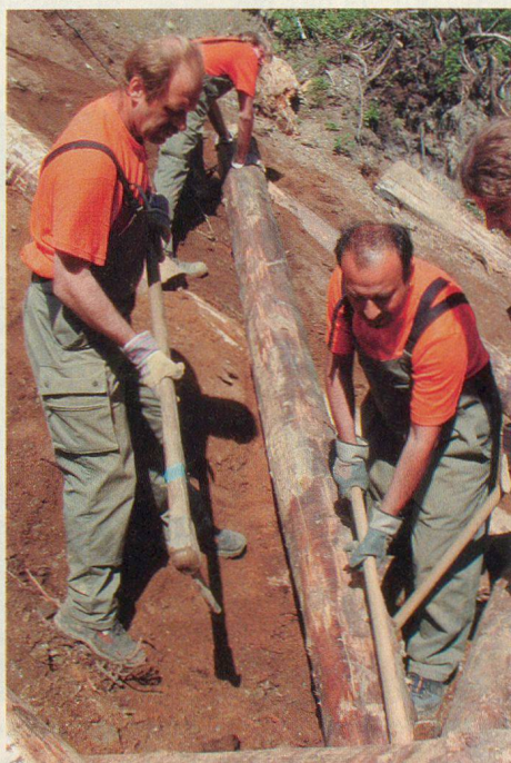
Sanierungsarbeiten oberhalb des Dorfes: Bachläufe freilegen, Hänge und Strassen vor dem Abrutschen sichern.
