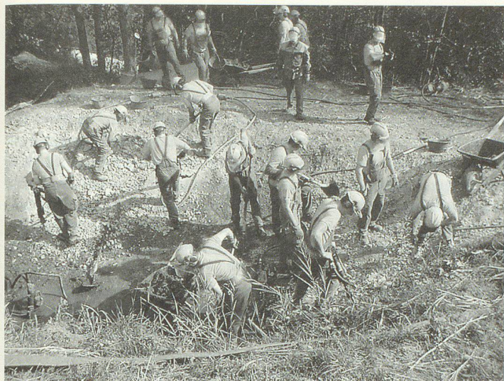
Der künstliche Weiher aus Beton musste abgetragen werden, um dem Hang wieder eine Stütze zu geben.
