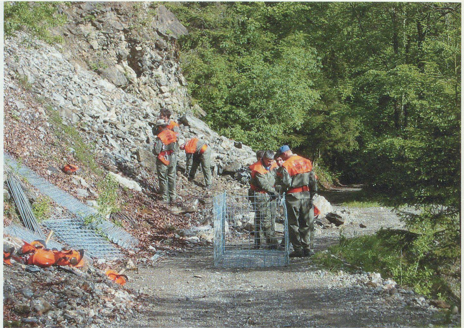
Das Rettungspikett beim Montieren von Steinkörben.
