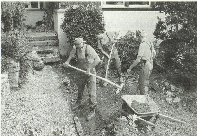
Im Garten vom «Chalet Schüpbach» errichten die Zivilschützer einen rollstuhlgängigen Weg.
