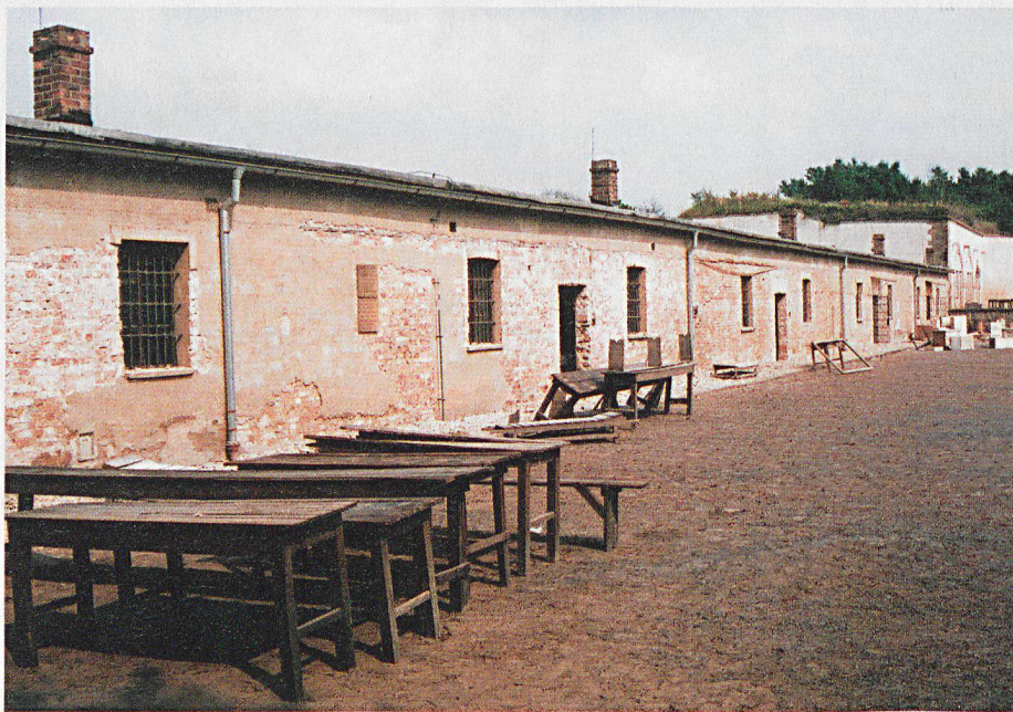
La Svizzera offre consulenza anche per il restauro degli intonaci della piccola fortezza di Terezin.
