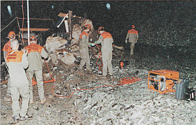
Pendant ce temps, la PCI installe un éclairage de secours.
