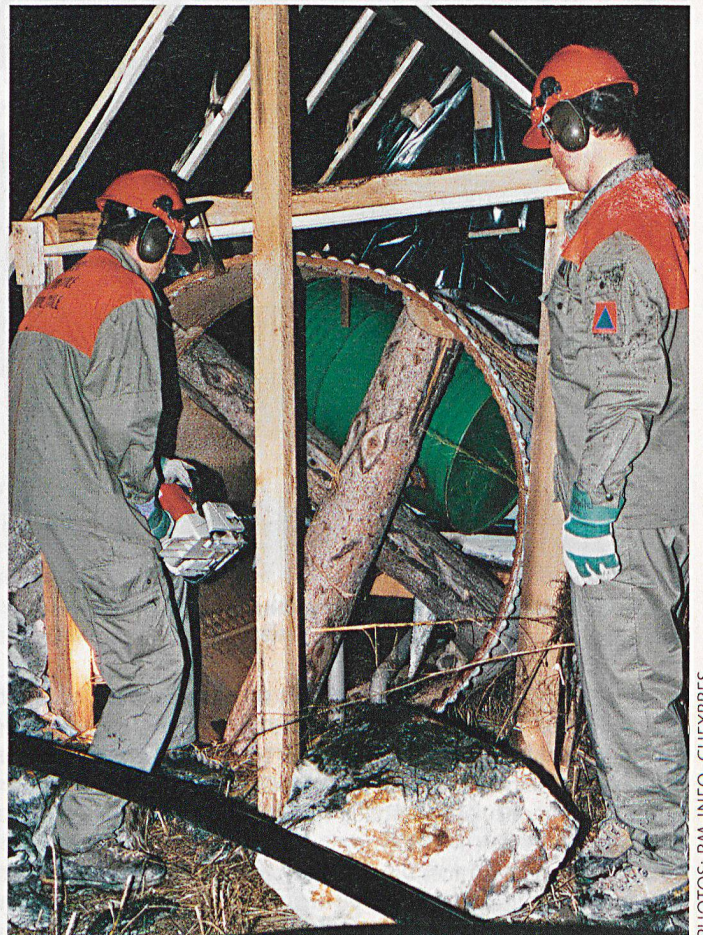
On dégage l'entrée d'un «bâtiment».
