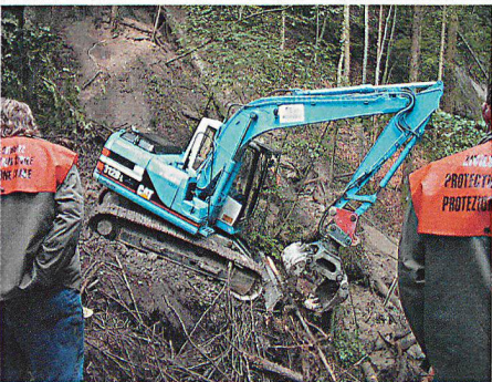
Die Ausserrhoder Zivilschützer arbeiten mit schwerem Gerät in unzugänglichem Gelände.
