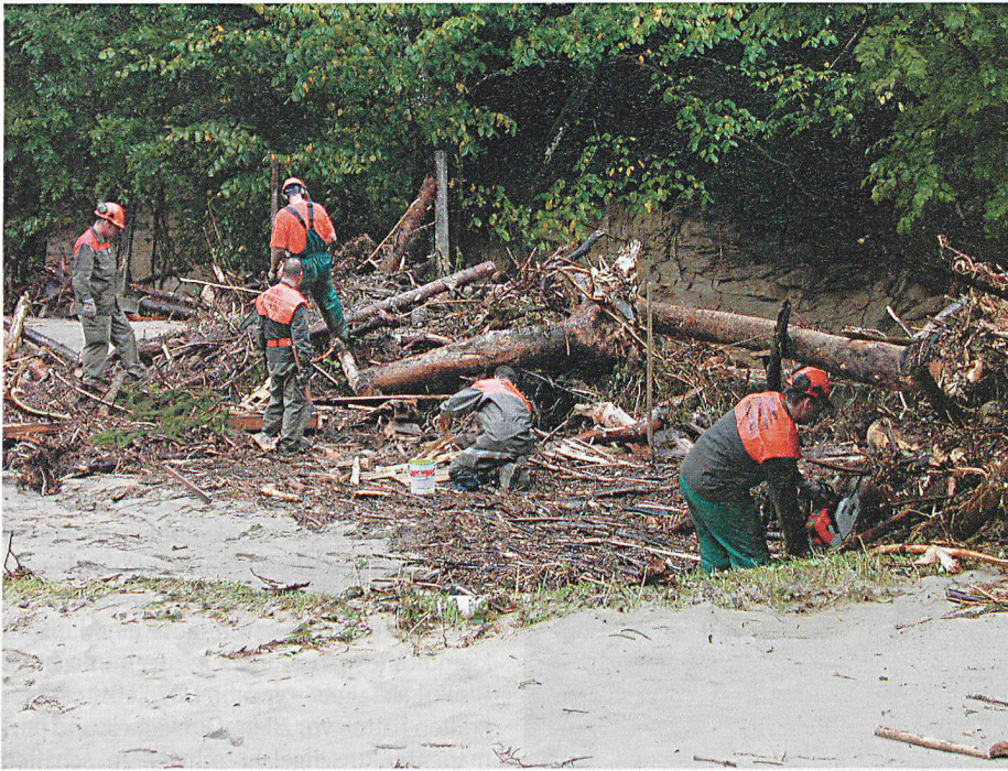
Die Flüsse brachten aus dem Appenzellerland grosse Mengen an Schwemmholz in den Kanton St.Gallen: Zivilschützer der RZSO St.Gallen beim Räumen.
