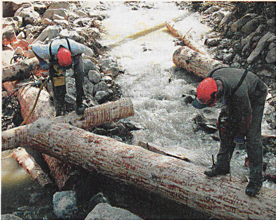
An den Uferböschungen der Goldach bei Trogen werden zur künftigen Hangsicherung schwere Holzkästen eingelassen, die mit Geschiebe aus dem Fluss gefüllt werden.
