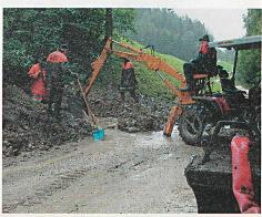
Mit Schaufel und Bagger werden die Bachdurchläufe freigelegt.
