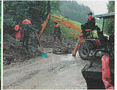
Mit Schaufel und Bagger werden die Bachdurchläufe freigelegt.
