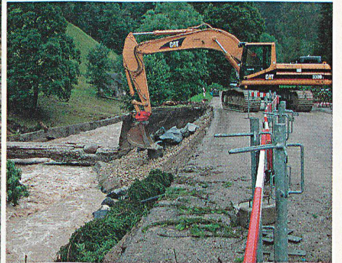
In der Sagibachstrasse von Trub wird das Bachbord mittels schwerer Baumaschinen gesichert.
