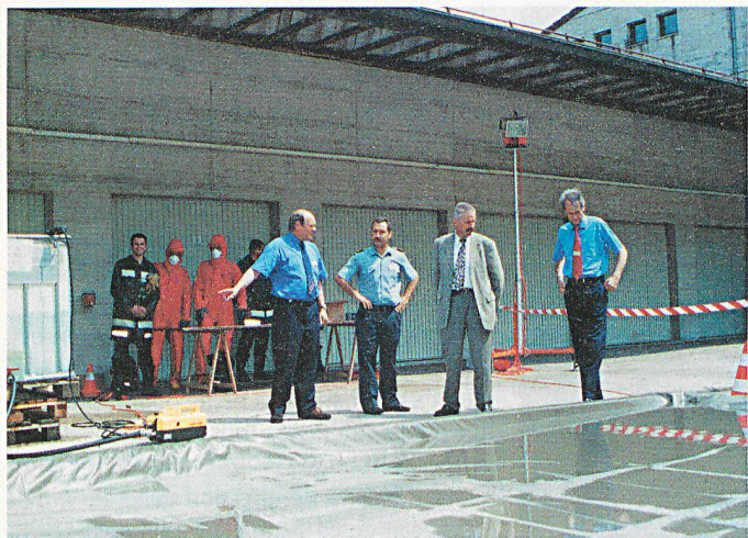
Zone de désinfection des véhicules avec bac de récupération.
