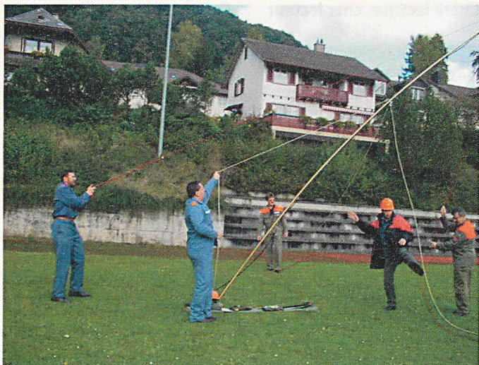
Das Aufbauen der Antenne...
