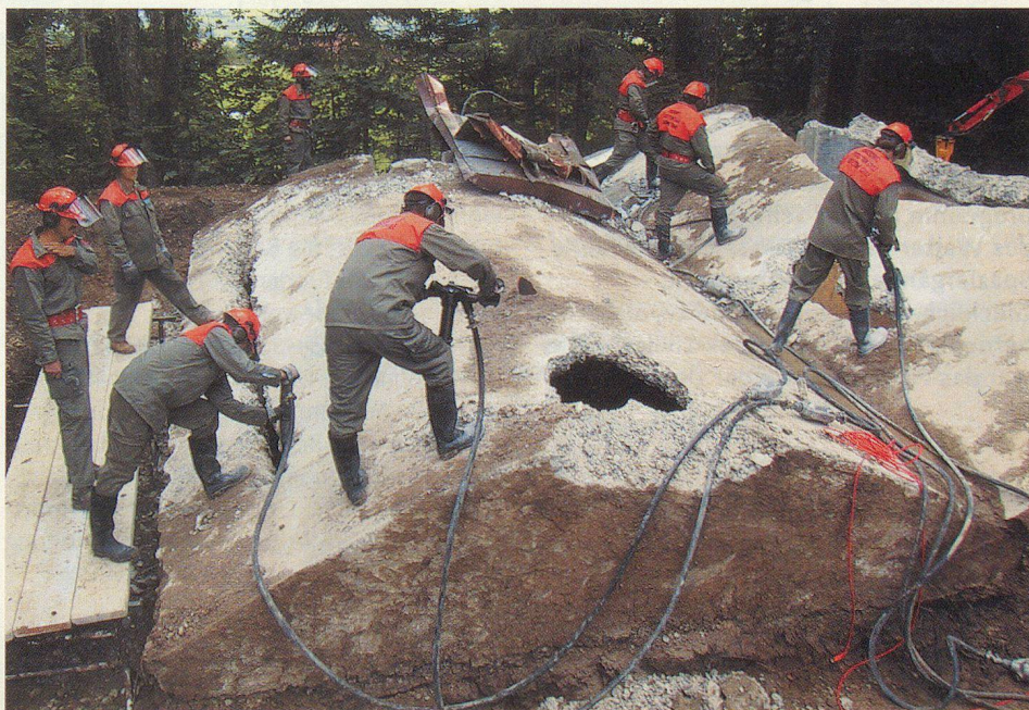
Schweisstreibender Einsatz beim Abbruch des 120-jährigen Reservoirs.
