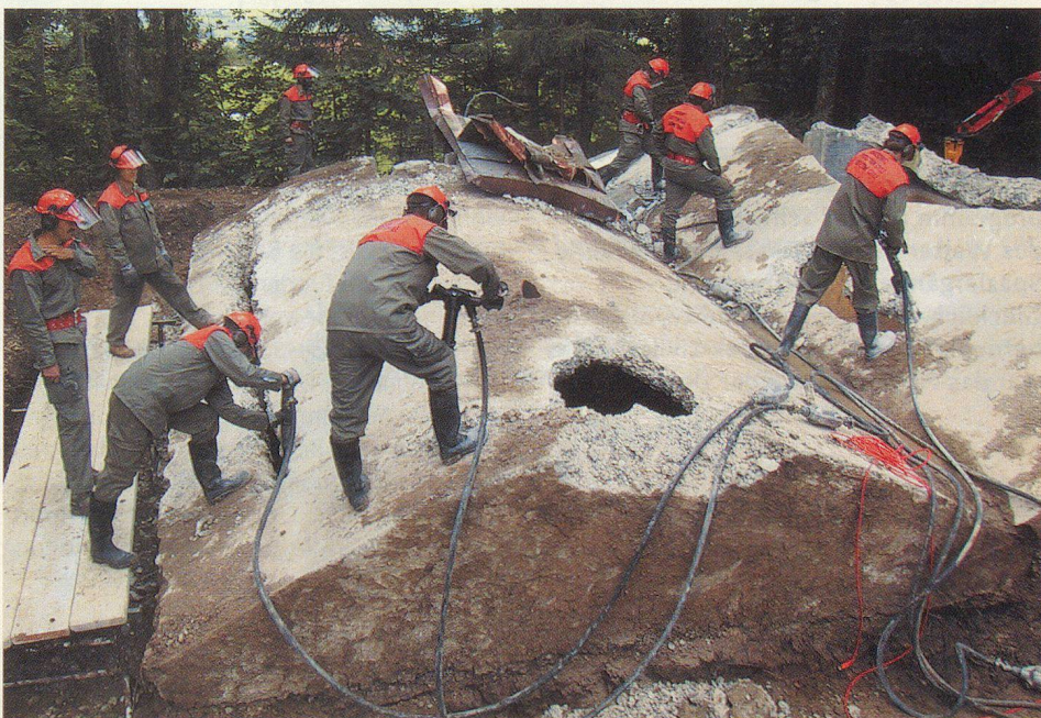
Schweisstreibender Einsatz beim Abbruch des 120-jährigen Reservoirs.
