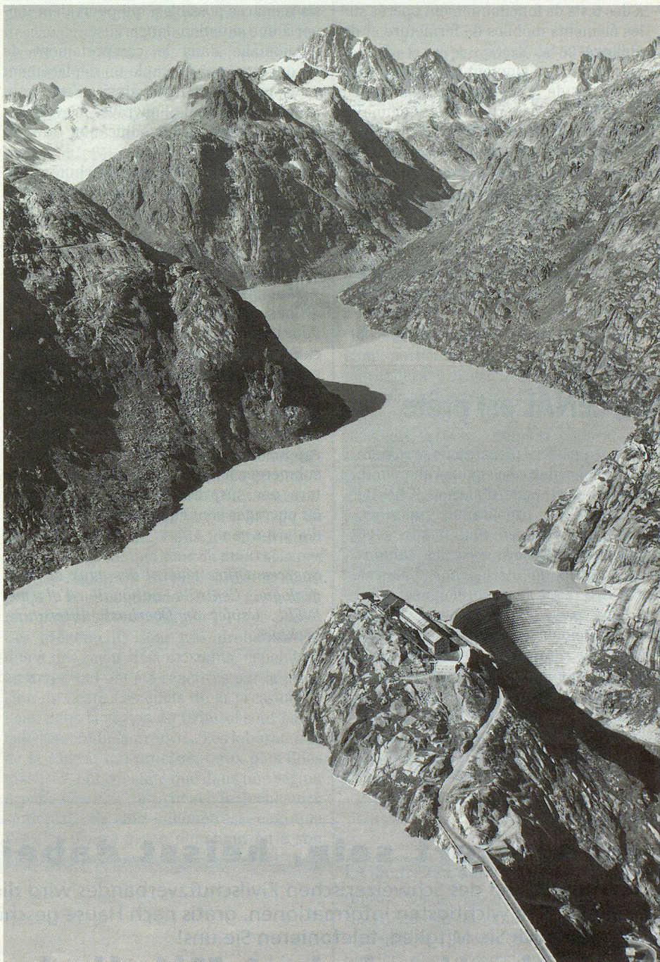
Le lac du Grimsel, d'une capacité de 100 000 mètres cubes; à droite, la «Spitallammsperre», un barrage en voûte de 114 m de haut et 248 m de long.
