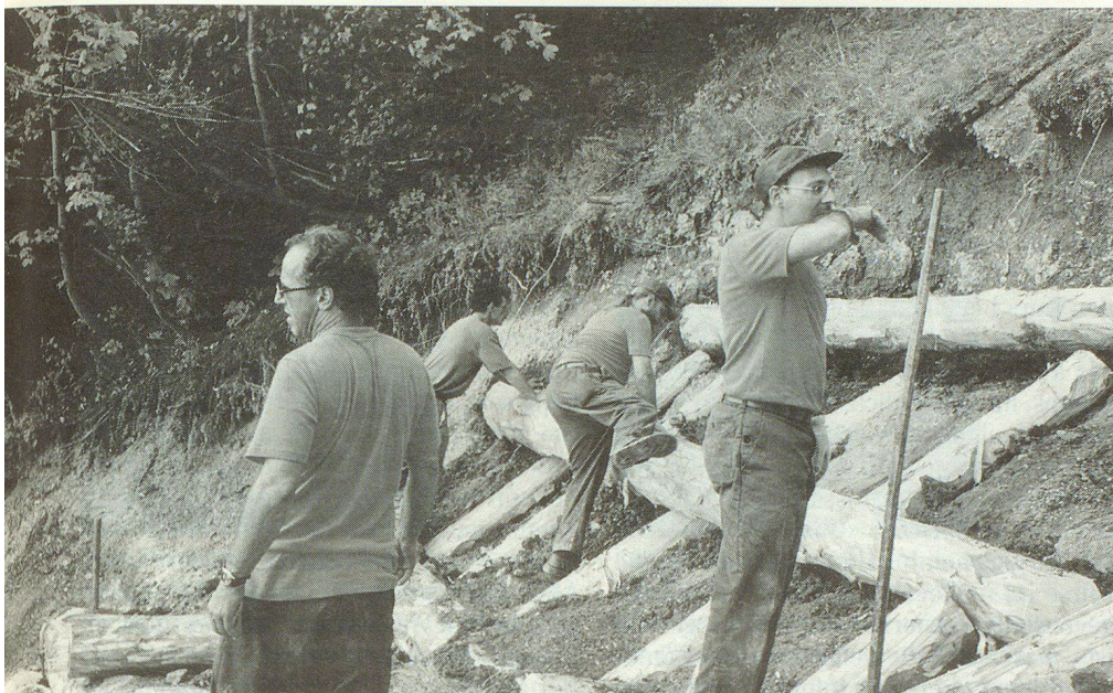
Eine Hangrutschung wird mit massiven Baumstämmen gesichert.
